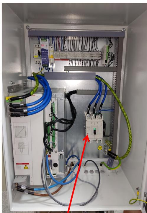
На приведенном выше изображении показан вводной автомат, к которому следует подключить сетевой кабель напряжением 380В переменного тока
