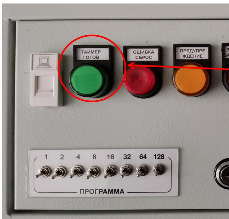
После завершения самопроверки загорится индикатор готовности таймера на главной панели управления, показанный на фотографии слева.
